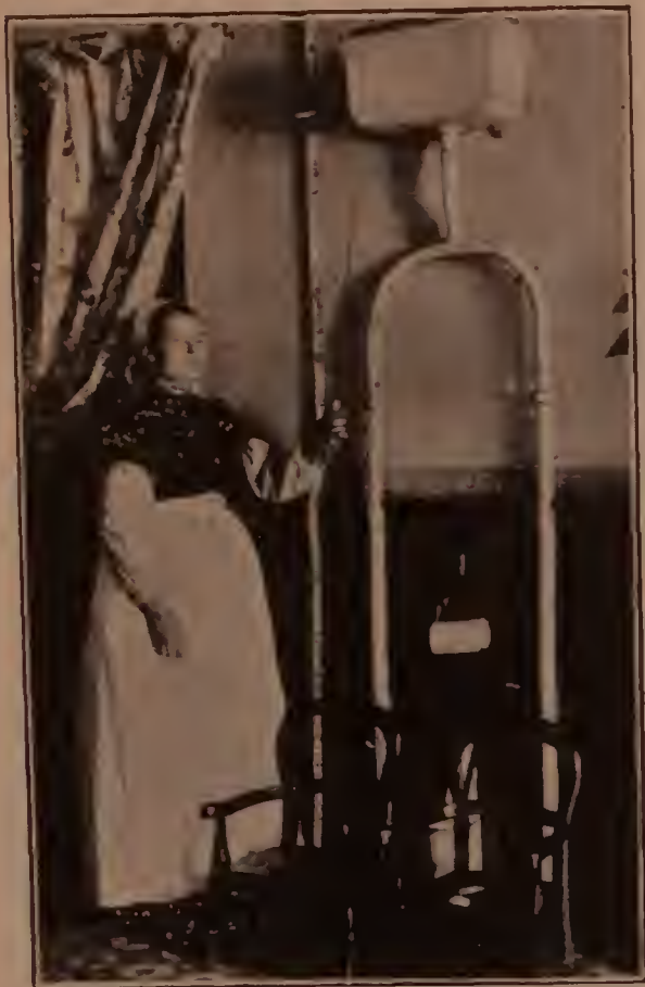
La salle de bains
